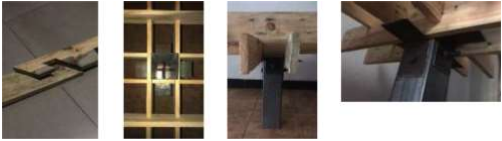
Figure 4: Ilustrasi konstruksi pemasangan papan kayu modular dengan tumpuan besi hollow
